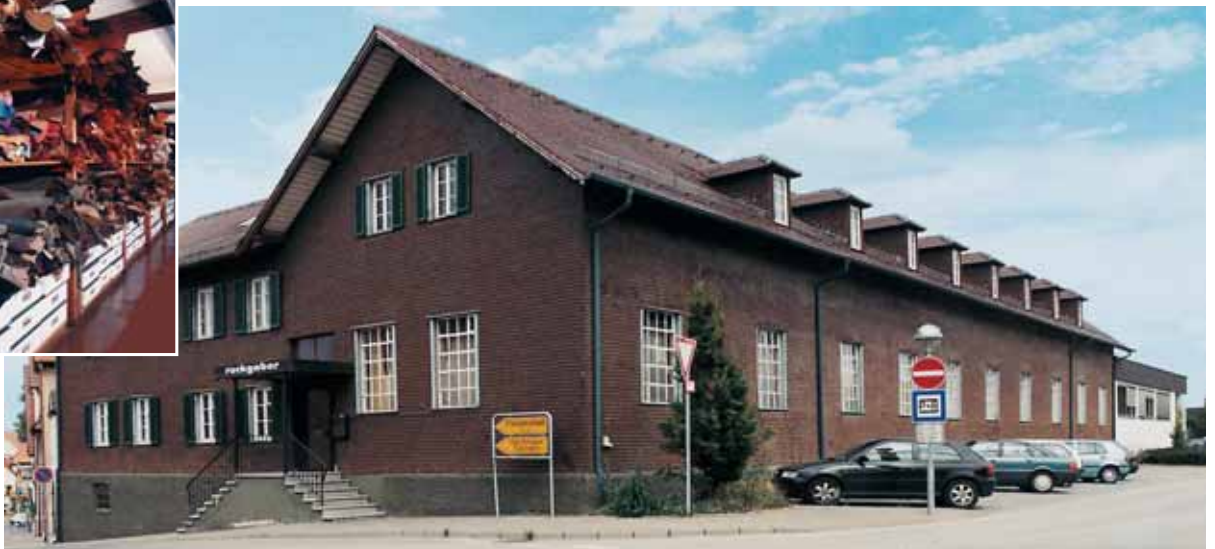
von 1902 bis 2002 der Firmensitz von Ruckgaber in Rottenburg
